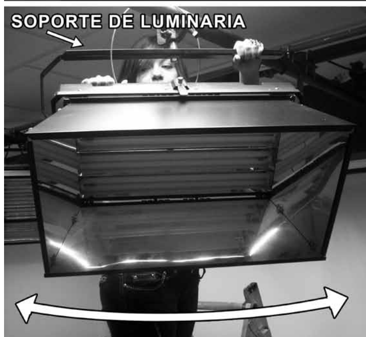
Fig. 4.15. Las luminarias pueden girar sobre su eje horizontal hacia izquierda o derecha, según lo requiera la producción. Para ello se debe sostener con firmeza el soporte de la unidad y con la mano derecha sobre el asa hacer el giro.
