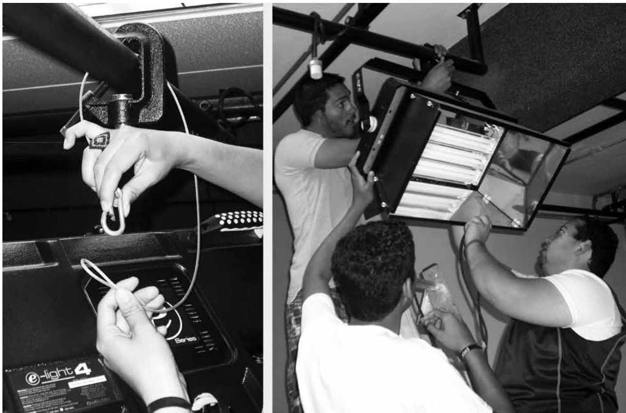
Fig. 4.19. La luminaria sólo deberá ser liberada del cincho cuando va a ser cambiada de sitio y esté perfectamente asegurada por quienes la sostienen desde abajo
