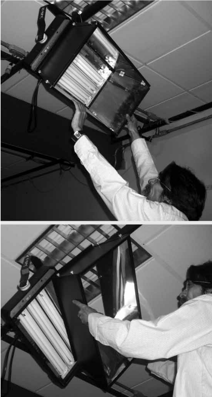
Fig. 4.20. Nunca se deberá intentar hacer movimientos desde abajo, sujetando la luminaria desde los refractores laterales; estos no son lo suficientemente fuertes ni firmes, por lo que podrían dañarse o incluso soltarse.
