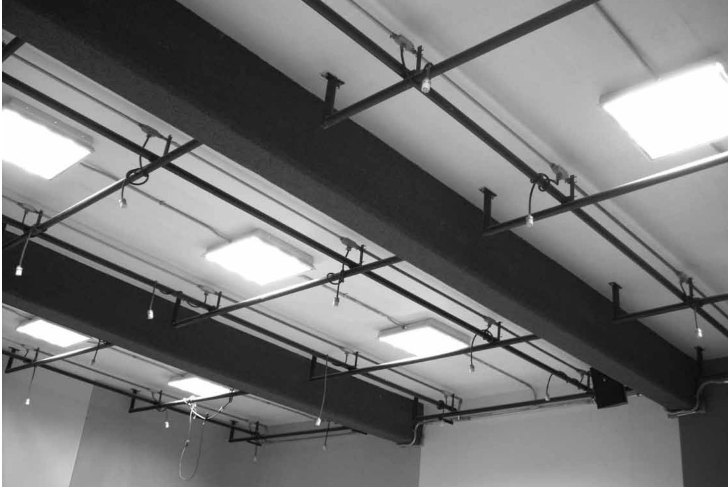
Fig. 4.3 Parrilla tubular superior para iluminación del foro de televisión con los contactos o tomas de corriente que penden de la estructura
